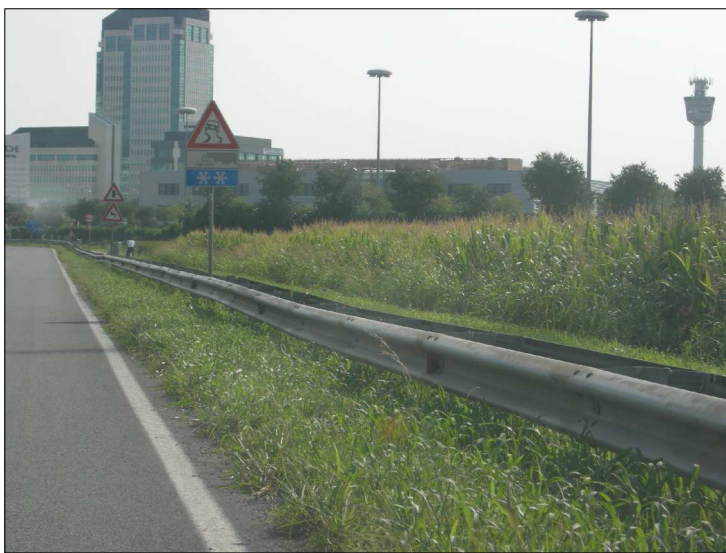
Posizione: Via Dante Tipologia: Impianti Conformi
