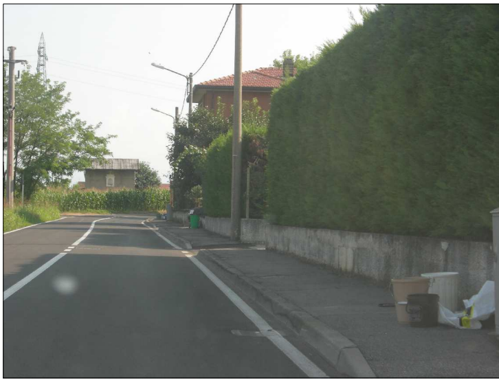
Posizione: Via Oreno Tipologia: Impianti Mancanti
