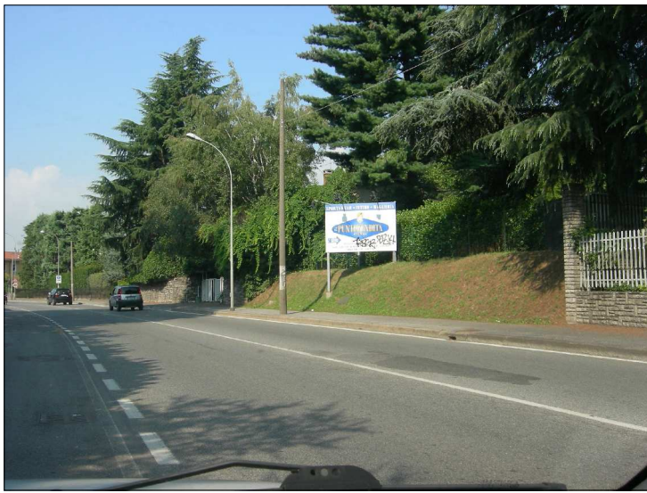
Posizione: Via Dante Alighieri Tipologia: Impianti Conformi
