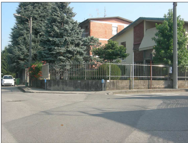
Posizione: Via S. Pellico Tipologia: Impianti Mancanti
