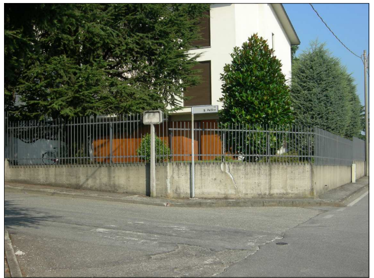
Posizione: Via Cattaneo - Via Pellico Tipologia: Impianti Mancanti
