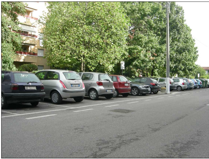
Posizione: Via Massironi Tipologia: Impianti Mancanti
