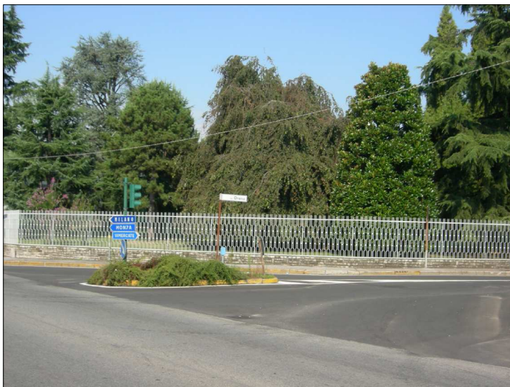
Posizione: Via D. Alighieri angolo via Oreno-Via Cattaneo Tipologia: Impianti Mancanti
