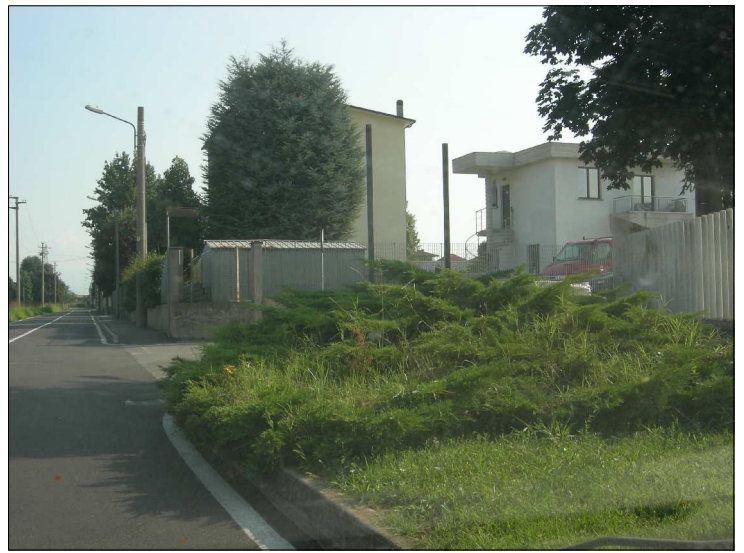
Posizione: Via Oreno incrocio Via Giovanni Pascoli Tipologia: Impianti Mancanti
