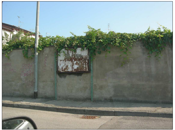
Posizione: Via F. Ozanam Tipologia: Impianti Nuovi (sostituito)
